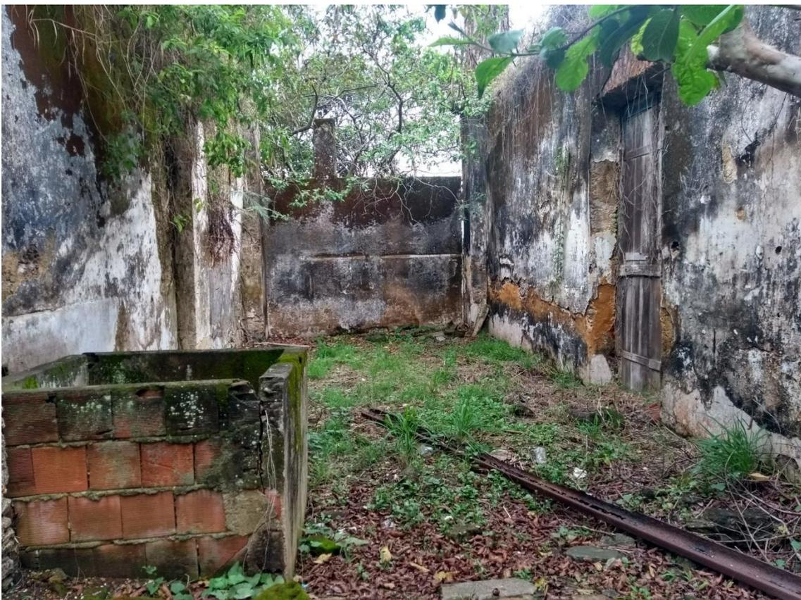
**Figura 52:** Cômodo do sobrado que ainda existe, sendo possível notar duas adições posteriores – a caixa de tijolos e uma viga metálica.
