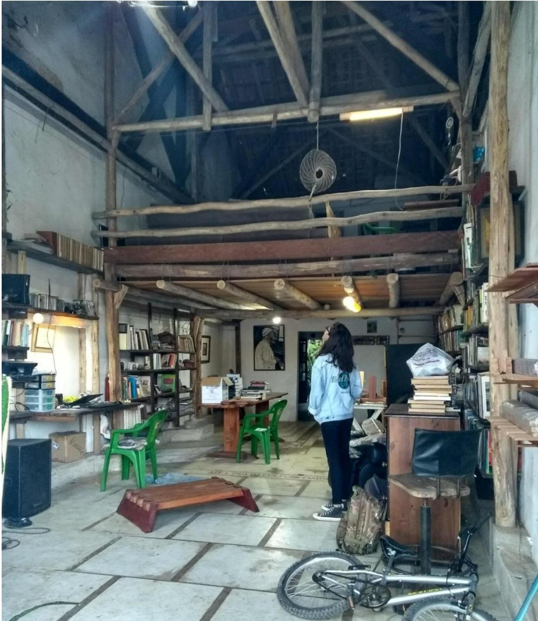
**Figura 66:** Sala da Oca Tamoia. Nota-se a estrutura de eucalipto, o segundo andar e a altura da casa. Foto autoral, 30/07/2020.
