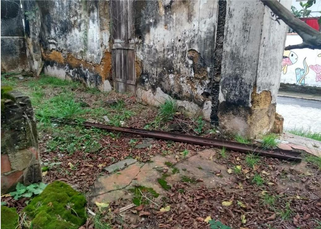
**Figura 47:** Paredes ainda de pé da ruína, viga metálica caída. É também possível ver o piso vermelho de cimento queimado, e, a esquerda, uma adição posterior feita com tijolos recentes e concreto. 23/09/2020
