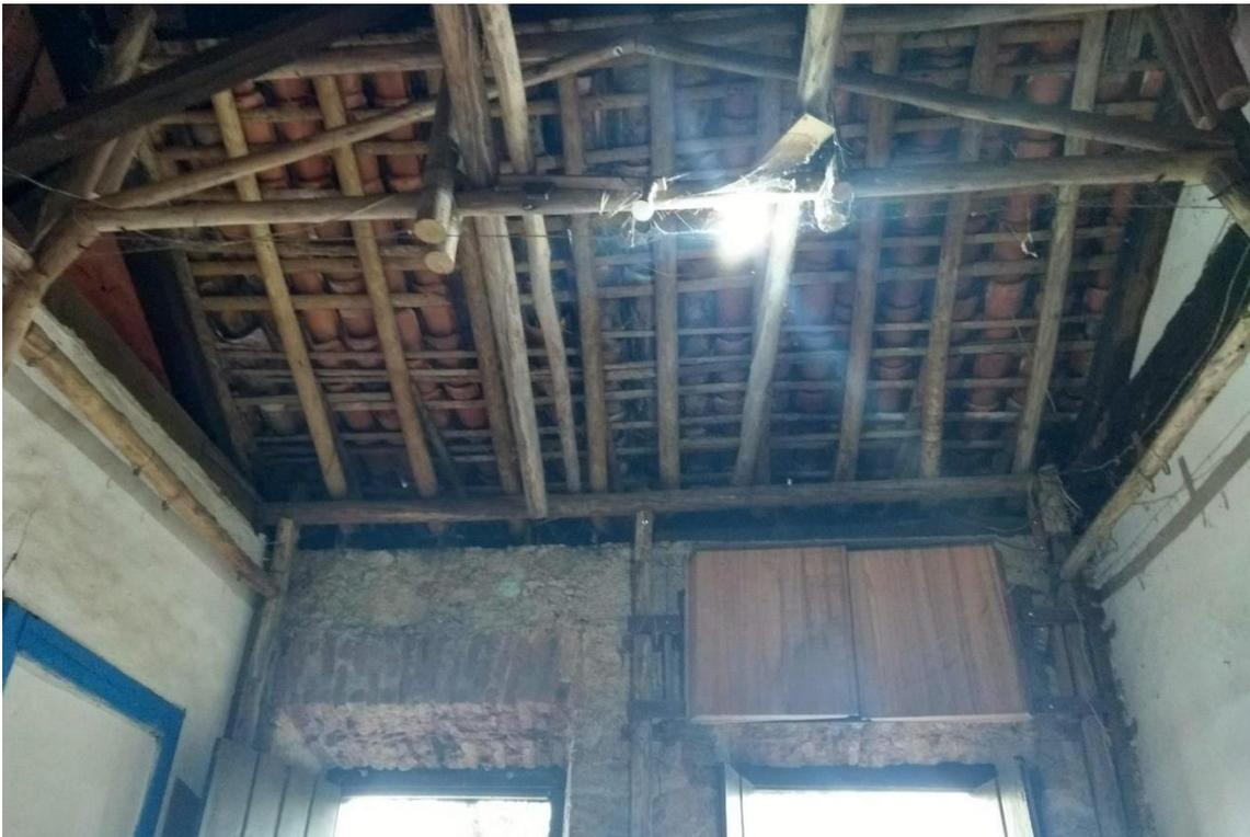
**Figura 68:** Parede frontal da Oca, estrutura de eucalipto, paredes e telhado da Oca Tamoia. Nota-se acréscimo de compensado do lado direito da estrutura do telhado. Foto autoral, dia 30/07/2019.
