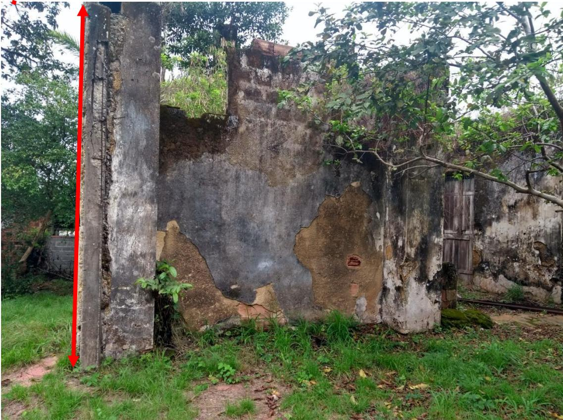
**Figura 53:** Pared de tijolos recentes e argamassa de barro e conchas, pilares coloniais, e, pilar recente de concreto em viga metálica – no pilar da esquerda. Foto autoral, 23/09/2020
